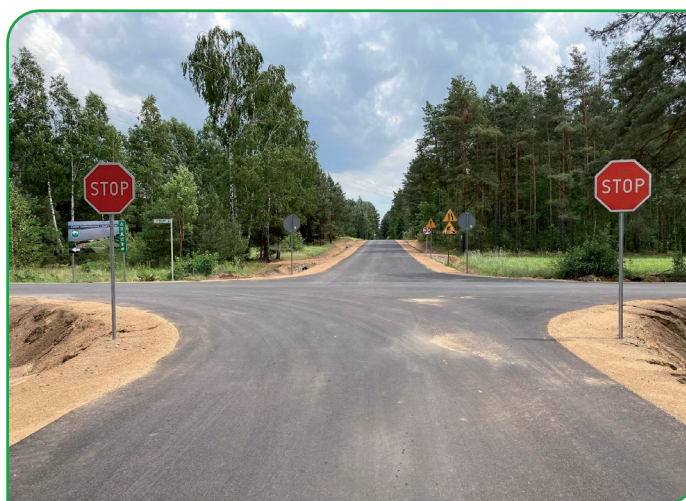
Nowa droga dojazdowa do OTRIK na Starym Dworze (Tarnopol - Nowa Łuka)
