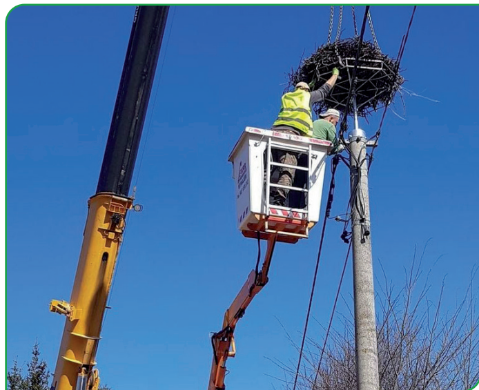
Instalacja platform na gniazda bocianie
